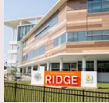
Hospital Building مبنى المستشفى
